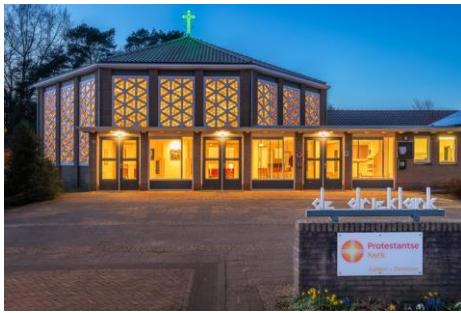
Gereformeerde Kerk Aalden (PKN)
